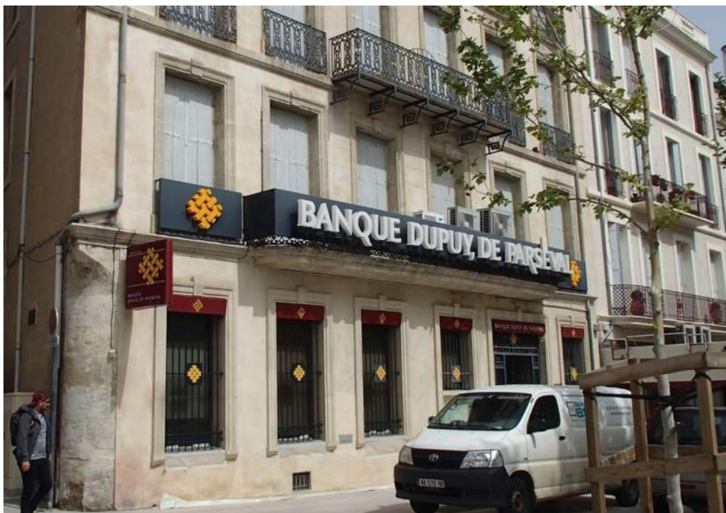
Recouvrement du balcon
