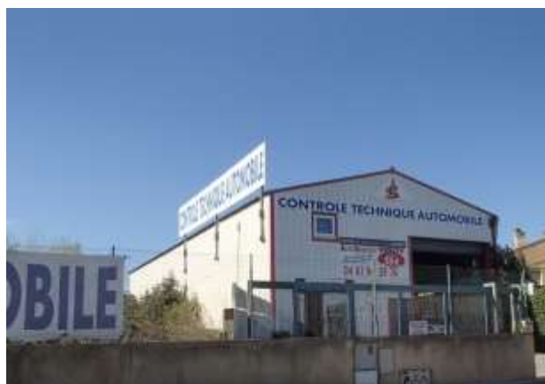
Enseignes sur toiture avec fond
