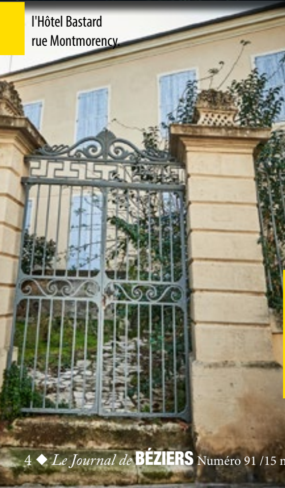
Anciens locaux du CCAS rue Boëldieu, la façade, la verrière et l'escalier monumental
